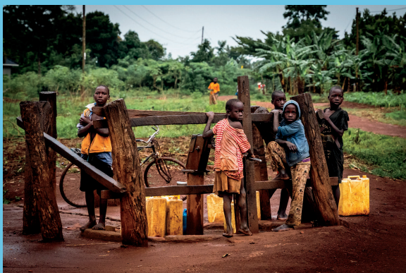
Pozo comunitario del centro de salud, Proyecto Aguay+ (Uganda).
